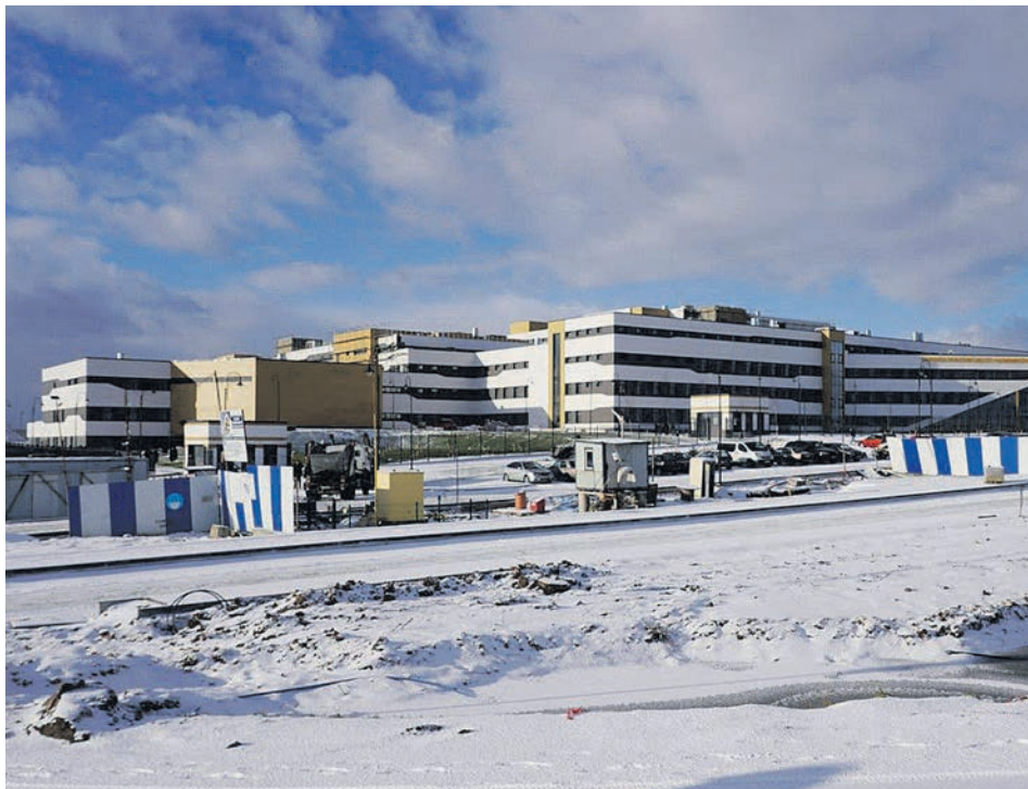
Онкоцентр. Подготовка к сдаче объекта в эксплуатацию продолжается.
